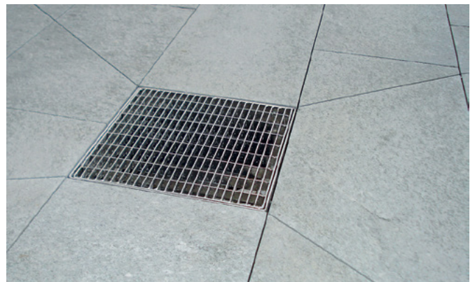
Abb. 16: Dachwassereinlauf: Gitterrost
