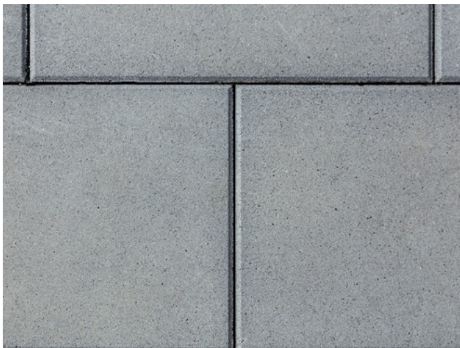
Abb. 9: Betonplatten mit gefasteten Kanten
