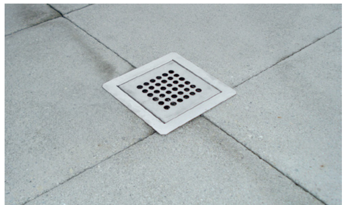
Abb. 17: Dachwassereinlauf: Lochrost
