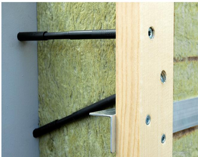
Fig. 2: Système avec vis d'écartement (Rogger)
