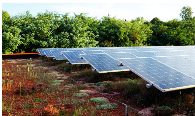
Installation solaire sur toit plat
