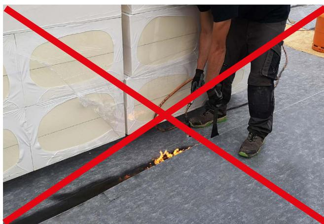
Fig. 19 : Potentiel de danger particulier lors du stockage des matériaux. Par effet de succion, la flamme peut être aspirée sous le matériel et l'enflammer depuis le bas.
