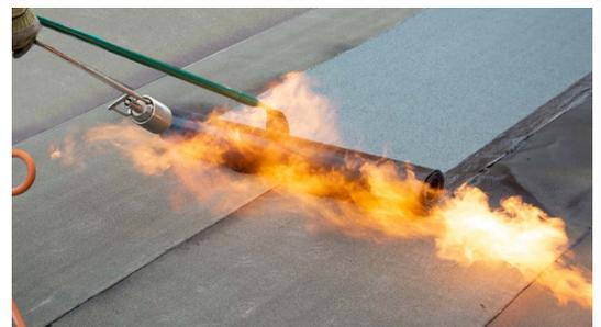
Fig. 20 : Exécution des travaux avec différents ensembles de combustion avec une flamme nue.
