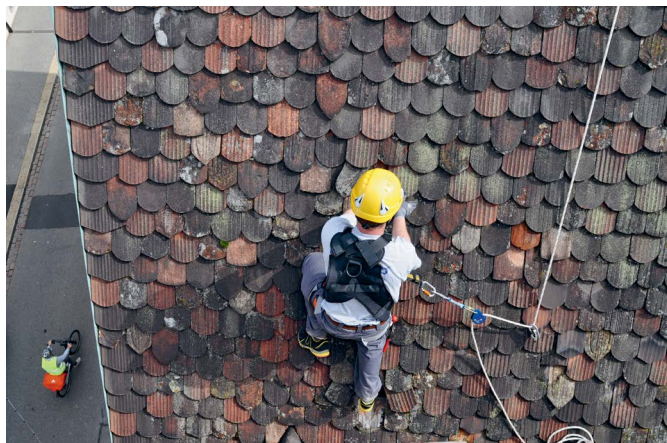
Fig. 4: protezione anticaduta da un frontone con bordo obliquo
