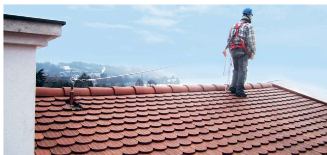
Fig. 3: classe di allestimento 1; ancoraggio puntuale
