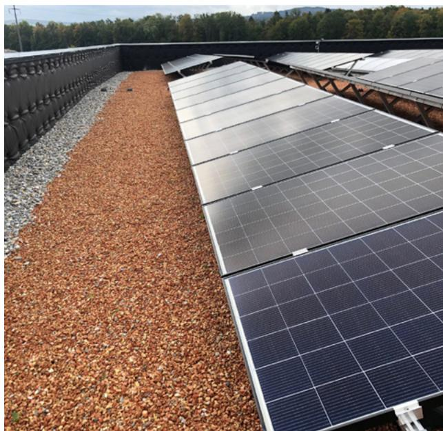
Figura 5: L'impianto fotovoltaico deve essere installato a sufficiente distanza da elementi strutturali adiacenti, attacchi a parete e simili, fonte: Contec
