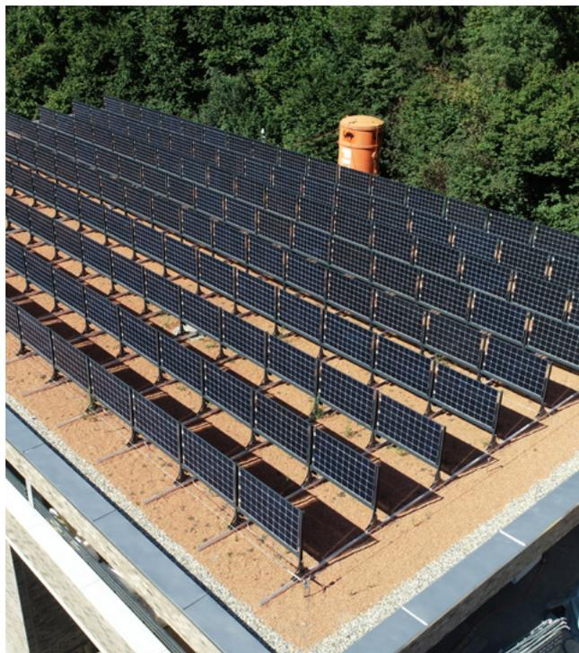
Figura 4: l'impianto fotovoltaico deve essere installato a sufficiente distanza dal bordo del tetto ( $\geq 60$  cm), fonte: reech gmbh
