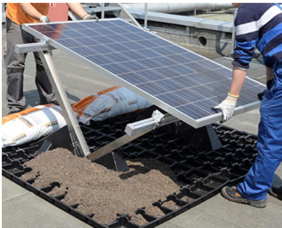
Figura 6: sistema di carichi sovrapposti per supporto a triangolo fotovoltaico, fonte: Bauder
