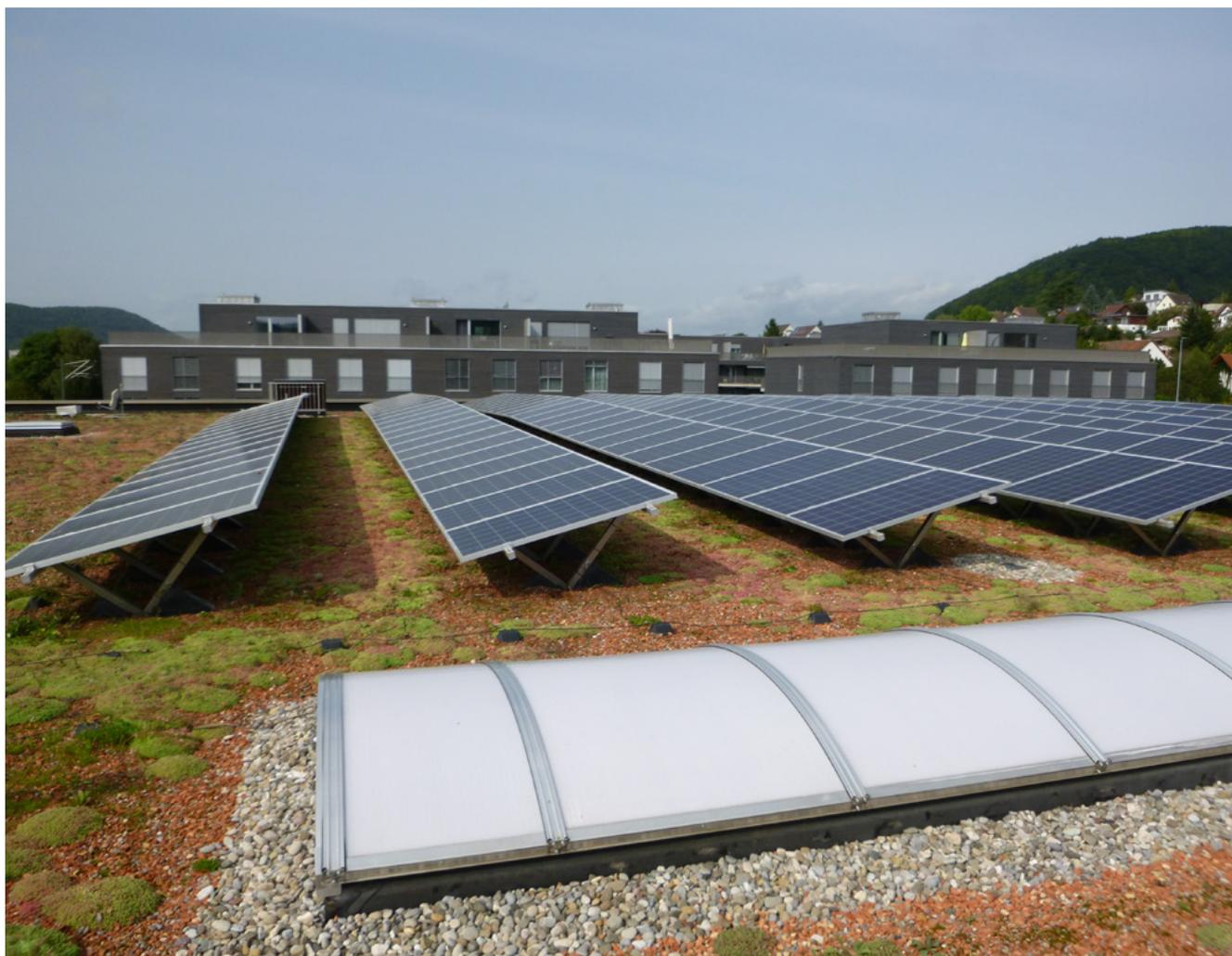
Figura 11: impianto fotovoltaico orientato a sud con substrato minimo, fonte: Contec
