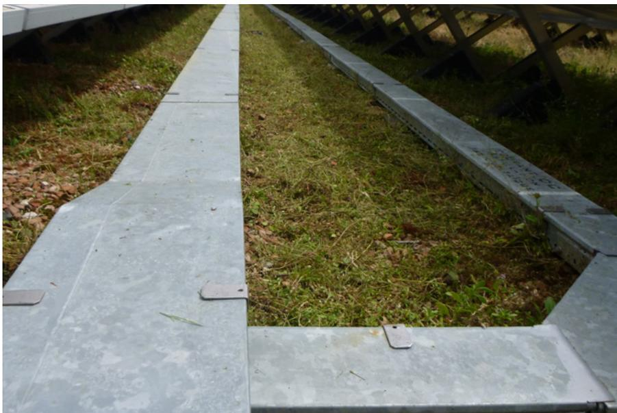
Figura 9: disposizione dei cavi tra i moduli fotovoltaici, fonte: Contec
