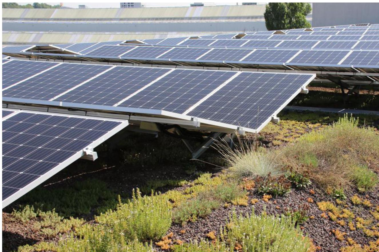
Figura 15: impianto fotovoltaico orientato a est/ovest con substrato minimo, fonte: Zinco
