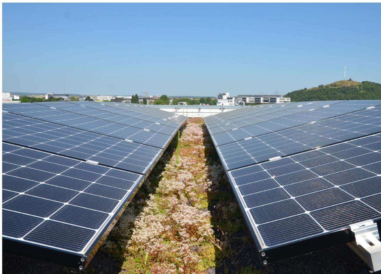
Figura 13: impianto fotovoltaico orientato a est/ovest con substrato minimo, fonte: Bauder
