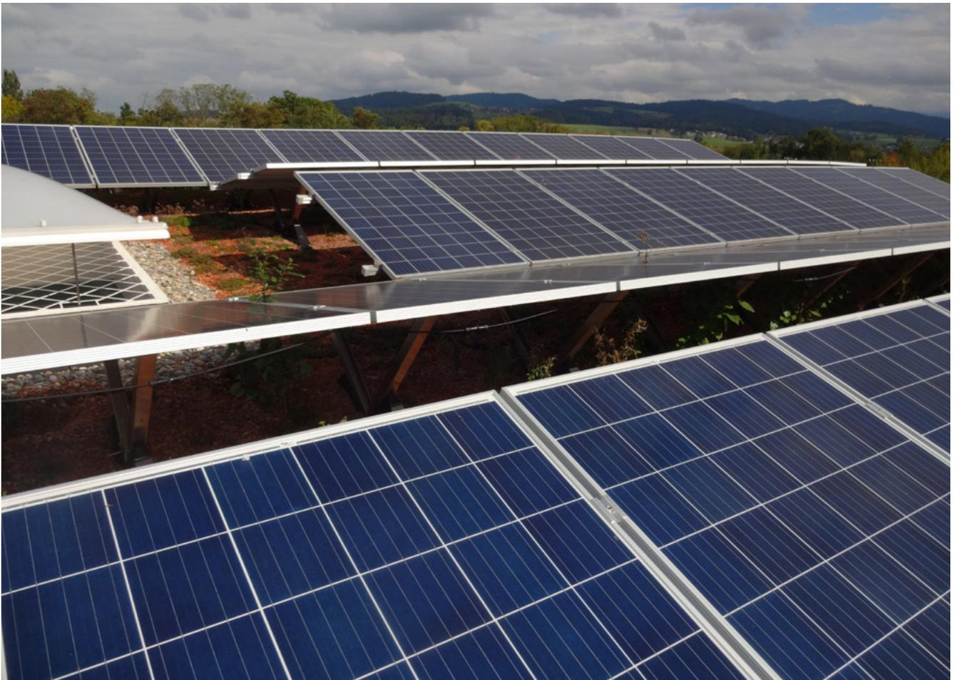
Figura 14: impianto fotovoltaico orientato a est/ovest con substrato minimo di diverse altezze, fonte: Contec
