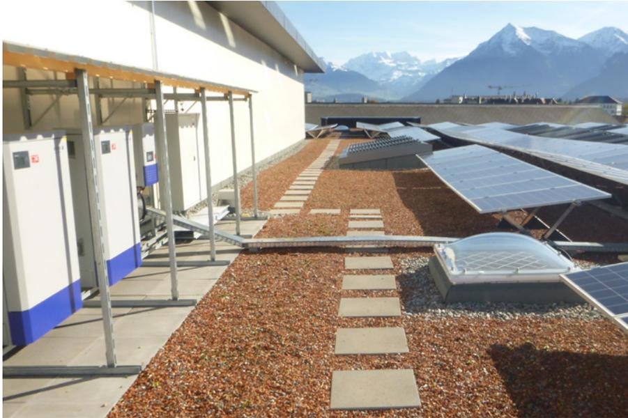
Figura 8: disposizione dei cavi dall'impianto fotovoltaico all'inverter, fonte: Contec
