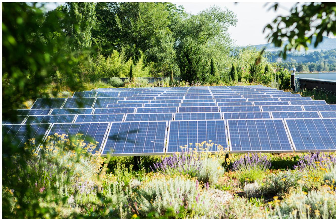
Figura 19: soluzione intelligente nella combinazione di inverdimento intensivo ed estensivo, insieme a un impianto fotovoltaico, fonte: Contec
