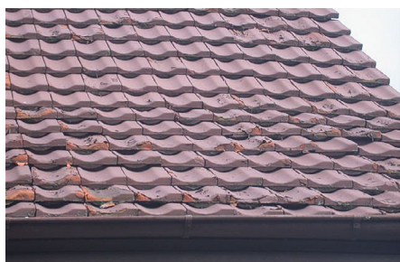
Schadhafte Beschichtung
