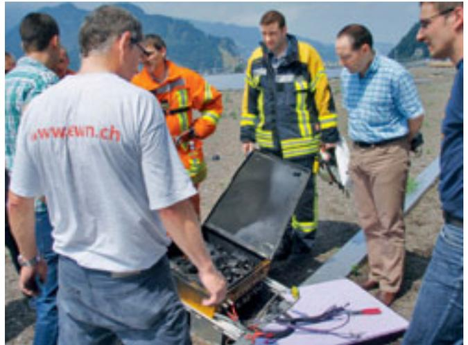
Am Dienstag, dem 13. Juli 2010, brach gegen Mittag ein Brand an der Solarstromanlage auf dem Dach des Einkaufszentrums Länderpark in Stans aus. In einem der Kästen, in denen die Leitungen der Solarpanels zusammengeführt werden, waren Kabel in Brand geraten. In Zusammenarbeit mit Mitarbeitern des Elektrizitätswerks Nidwalden trennte die
