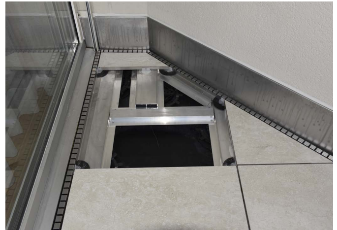
Abb. 20: Schienensysteme dienen für eine optimale Verlegung der Plattenbeläge und ermöglichen insbesondere bei orthogonal schwierigen Anschlüssen die fachgerechte Ausführung.
