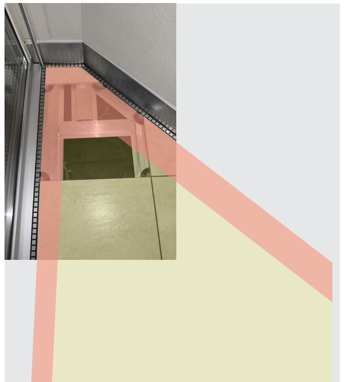
Abb. 20: Schienensysteme dienen für eine optimale Verlegung der Plattenbeläge und ermöglichen insbesondere bei orthogonal schwierigen Anschlüssen die fachgerechte Ausführung.
