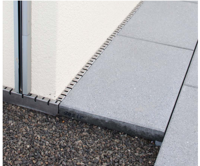
Abb. 33: Randanschluss mit Fugenprofil.
