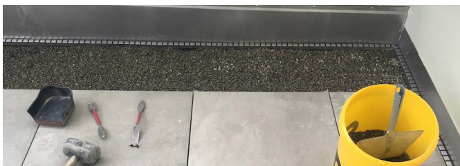
Abb. 5: Verlegung der Keramik-/Feinsteinzeugplatten in Bettungsschiicht aus Rundkies.
