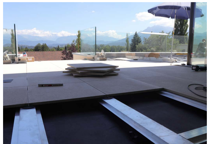
Abb. 7: Verlegung der Keramik-/Feinsteinzeugplatten auf Schienensystem.
