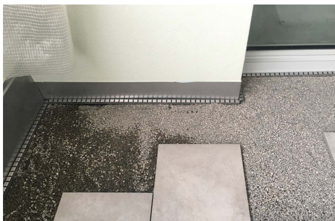
Abb. 24: Terrasse mit Keramik-/Feinsteinzeugplatten in Bettungsschicht verlegt.
