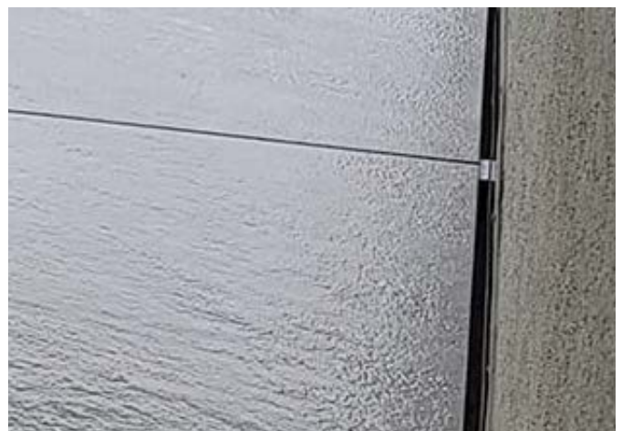
Abb. 35: Anschlussfuge \geq 10 mm mit Distanzhalter.
