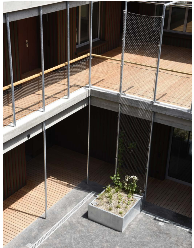
Abb. 10: Terrassen und Laubengänge mit Holzrost.
