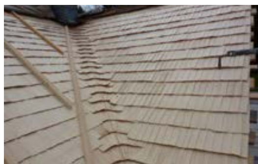
Abb. 22 Schindelunterzug Vorallem bei älteren Gebäuden weit verbreitet. Spätere Dachmodernisierungen sollten in die Planung einer Solaranlage miteinfließen.
