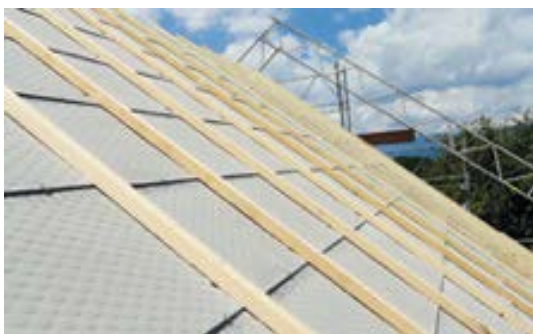
Abb. 18 Geschupptes Plattenunterdach (Faserzement / Holz) Kann Asbest enthalten (älter als 1991). Durchdringungen durch das Plattenunterdach funktioniert nur an bestimmten Stellen (Herstellerangaben).
