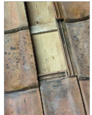
Abb. 3 Ziegel demontieren
