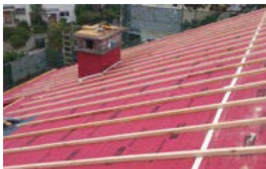
Abb. 21 Folienunterdach (Unterdachbahn) Bei den Unterdachbahnen gibt es drei Beanspruchungskategorien. Durchdringungen durch das Unterdach müssen fachgerecht abgedichtet werden. Evtl. die Funktionsfähigkeit der Folie überprüfen lassen.
