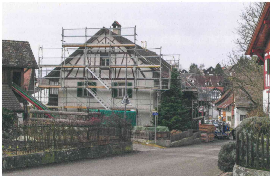
Ausgangslage: Das 1906 erbaute Bauernhaus mit Scheune im Dorfkern von Buchberg SH wird in drei Etappen energetisch saniert.
