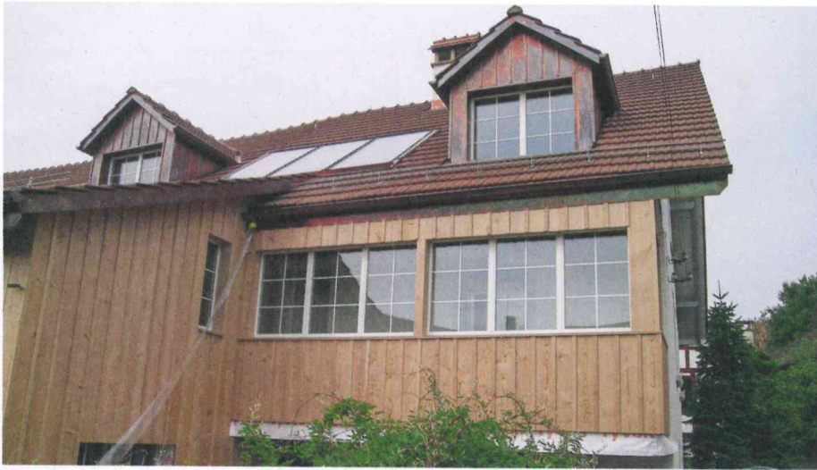
Montage einer Solarthermieanlage.
