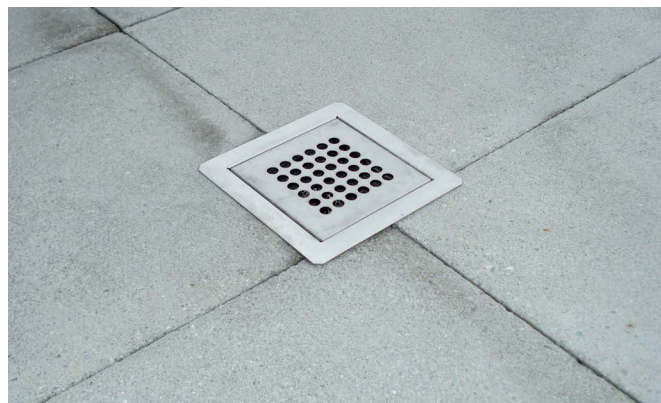
Fig. 17: Naissance d'eau pluviale : grille perforée
