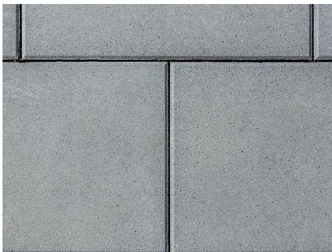
Fig. 9: Dalles en béton à bords chanfreinés
